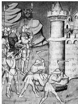
Installation de charges explosives à la base du rempart
